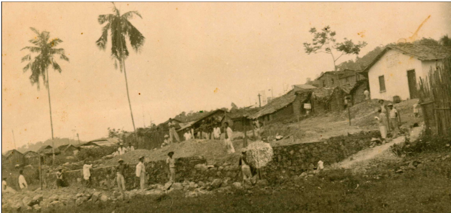
Figura 13 – Fotografia de trabalhadores “Negros, índios, beiradeiros-migrantes” numa obra pública em Ubatã, próximo ao Rio de Contas, nos anos 1920
